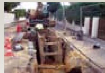
**En cours :** Avenue et Square du Bosquet. Les travaux d'assainissement démarrés le 10 août 2009, consistent à remplacer les anciennes canalisations vétustes par des tuyaux PVC d'un diamètre variant de 315 mm à 400
