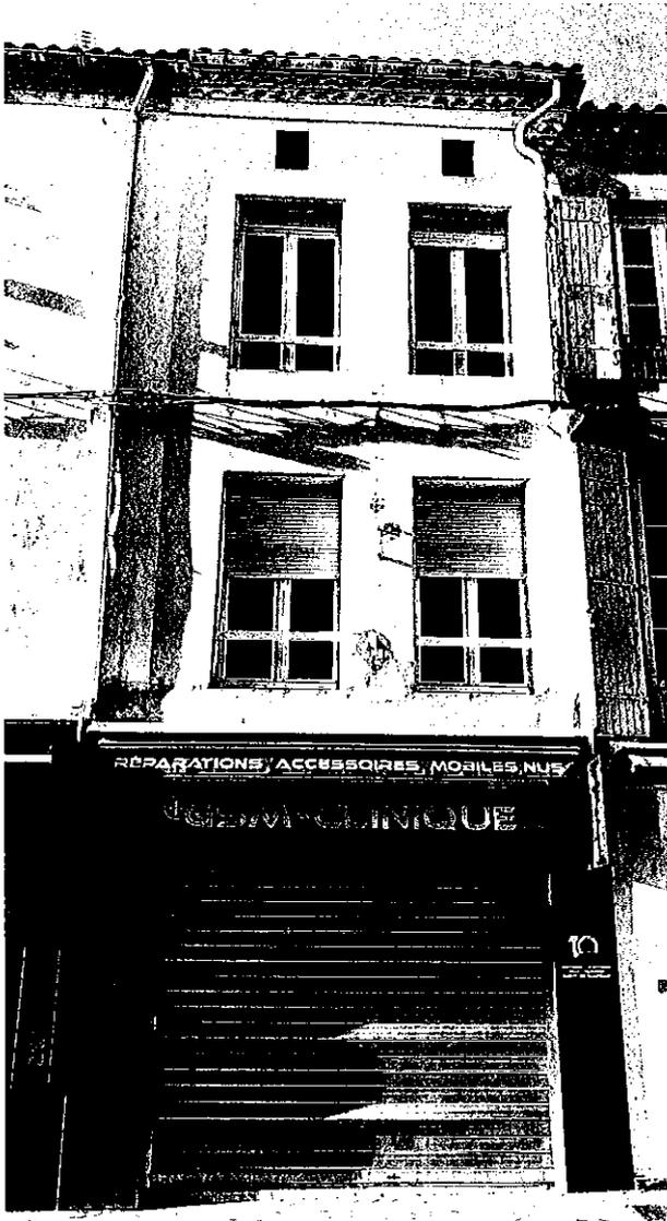
Façade à nettoyer à l'eau sous pression et à traiter avec un anticryptogamique
