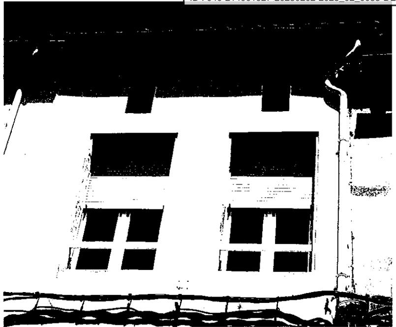
Façade à nettoyer à l'eau sous pression et à traiter avec un anticryptogamique
