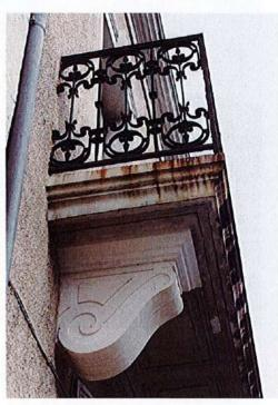
Pierres du balcon à nettoyer. Garde-corps à décaper, traiter et repeindre. Etanchéité à réaliser sur le dessus du balcon.
