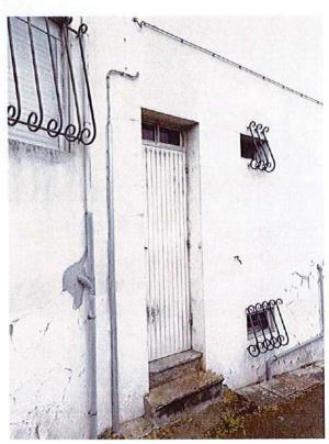
Porte et fenêtres à décaper et repeindre. Grilles à décaper, traiter et repeindre. Canalisations à peindre.
