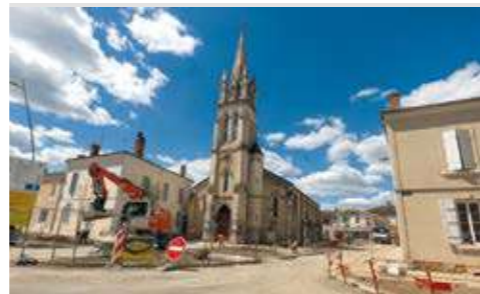
Le nouveau parvis de l'église de Saint-Jean-d'Août va permettre de mettre en valeur cet édifice historique. Les aménagements du début du boulevard d'Haussez et de la fin du boulevard de Candau offriront une porte de cœur de ville qualitative aux habitants.
