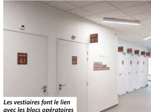
Les vestiaires font le lien avec les blocs opératoires
