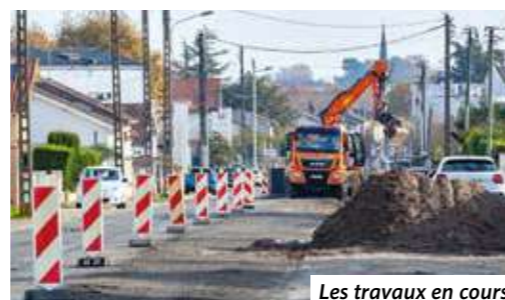
Les travaux en cours
