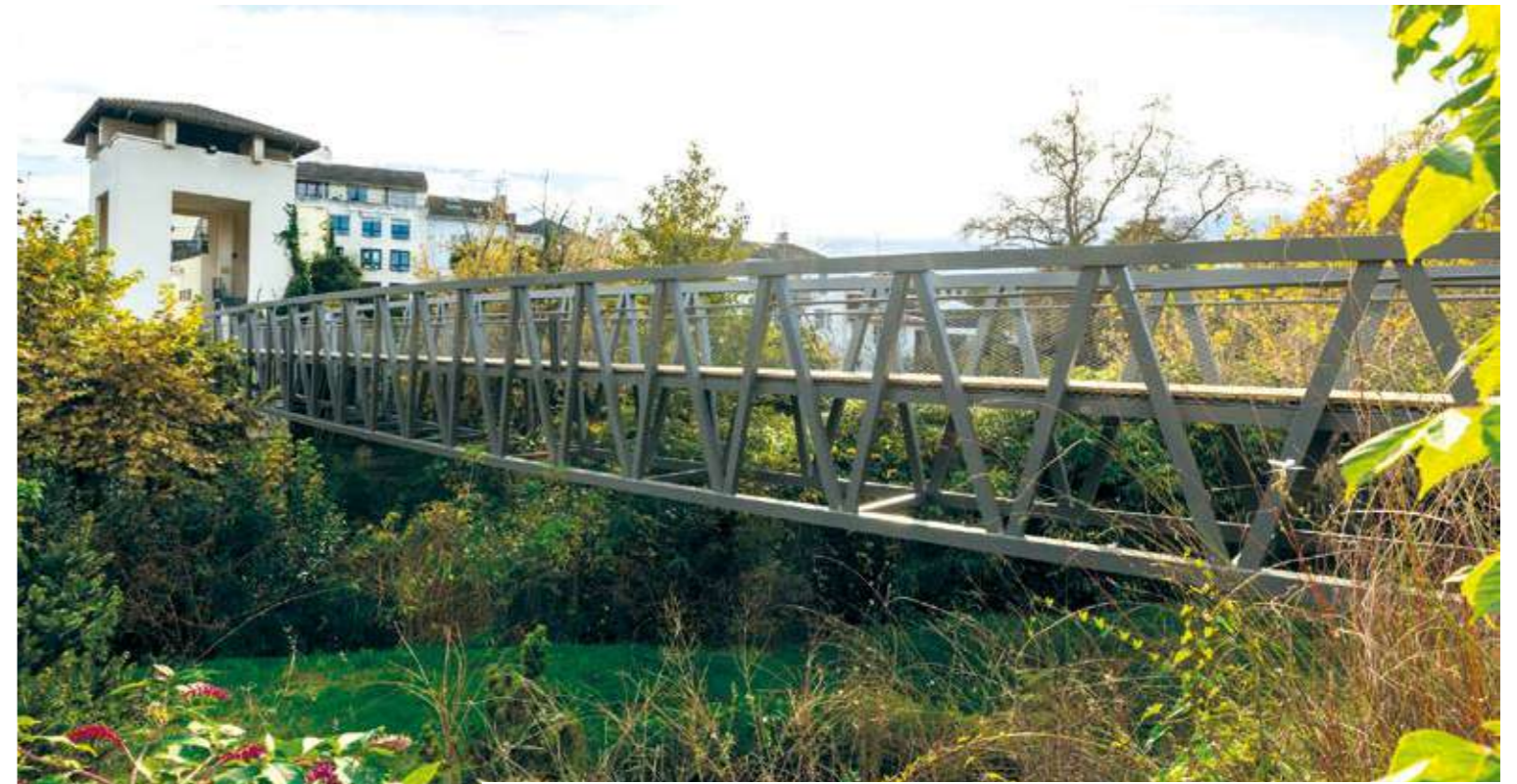
La passerelle désormais en place
