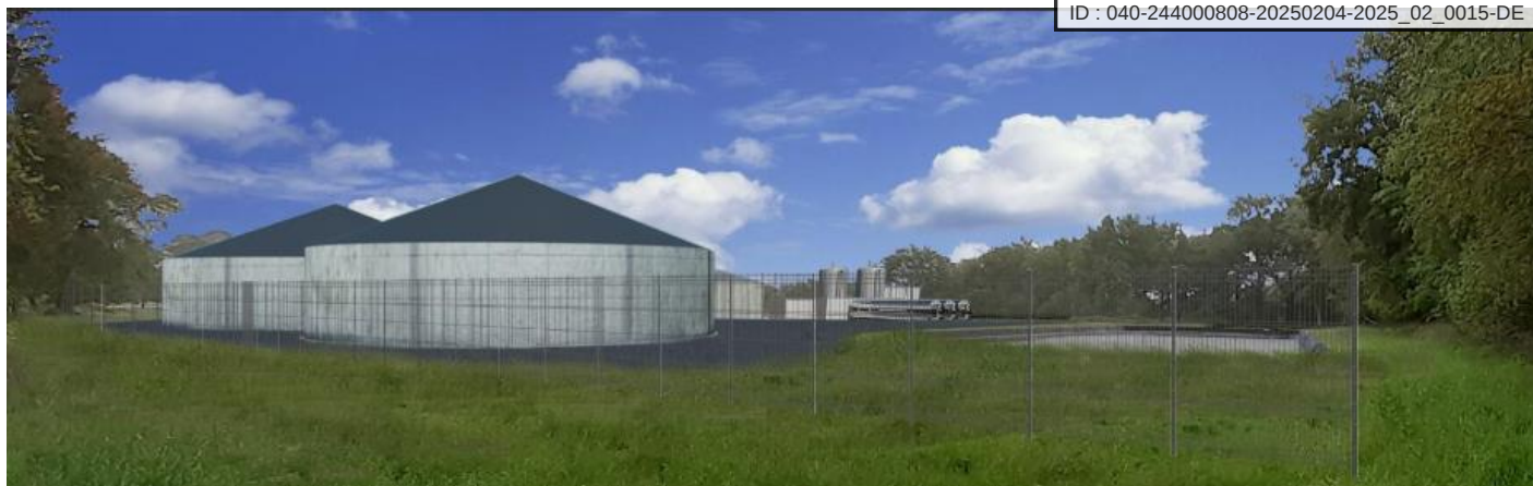
Photo 3 : Vues du site après la création des cuves de stockage digestat
