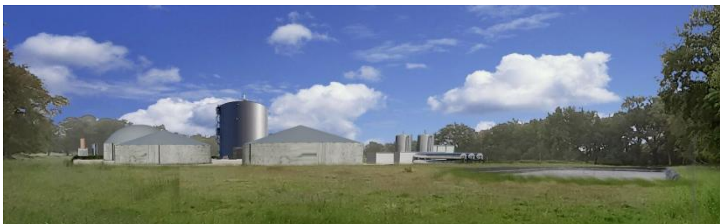
Photo 2 : Vues du site avant la création des cuves de stockage digestat
