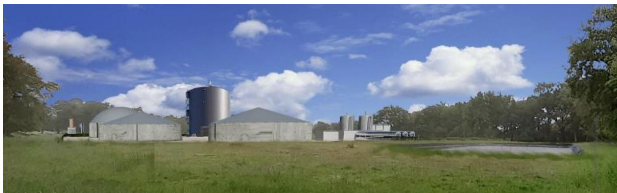
Figure 4 : Vues du site avant la création des cuves de stockage digestat
