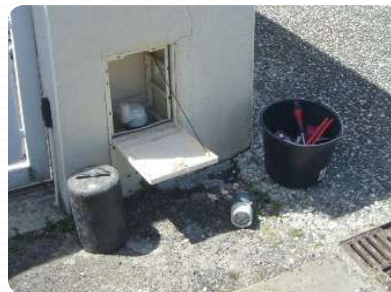
Changement d'un ancien compteur par un télérelevé
