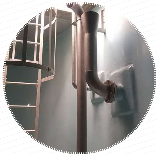
Vue du réservoir de la station de reprise de Saint-Avit
