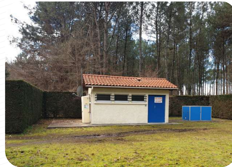
| Vue d'un forage d'eau potable
