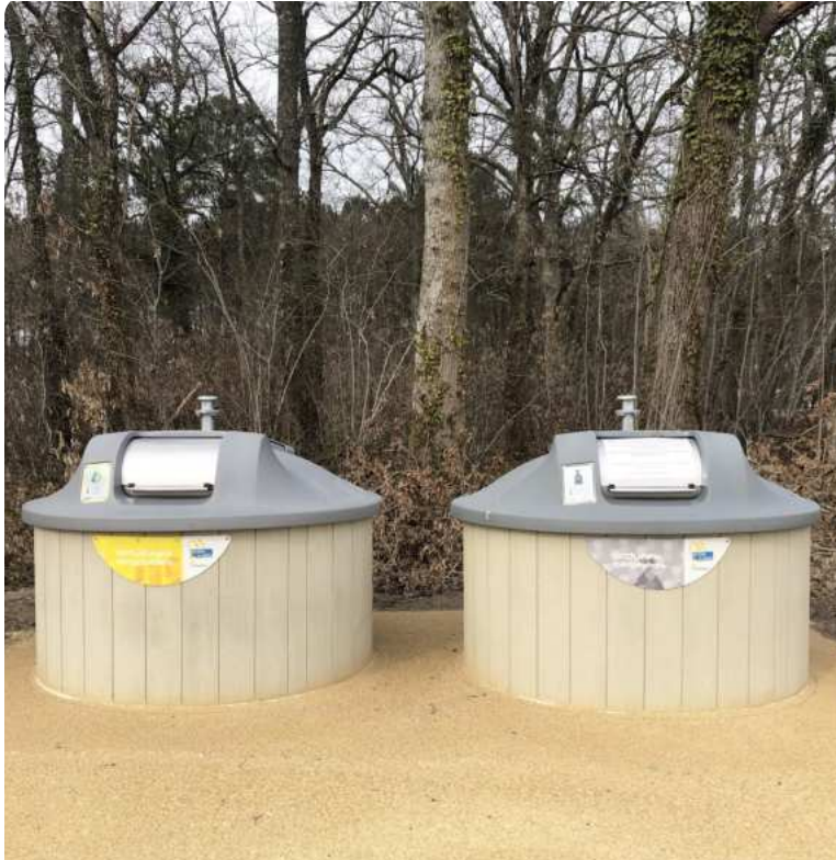
Conteneurs semi-enterrés installés sur la commune de Créon d'Armagnac
