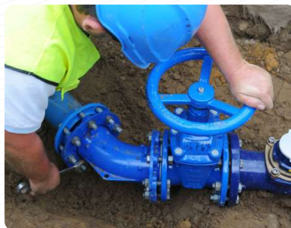
Intervention sur réseau d'eau potable
