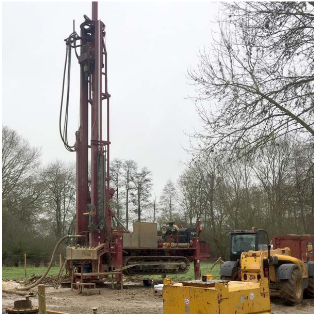
Vue d'une unité de rechemisage d'un forage
