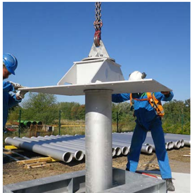
Vue d'un rechemisage d'un forage
