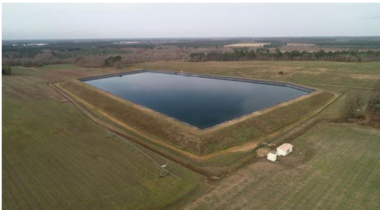
Photo du bassin de stockage à Mazerolles
