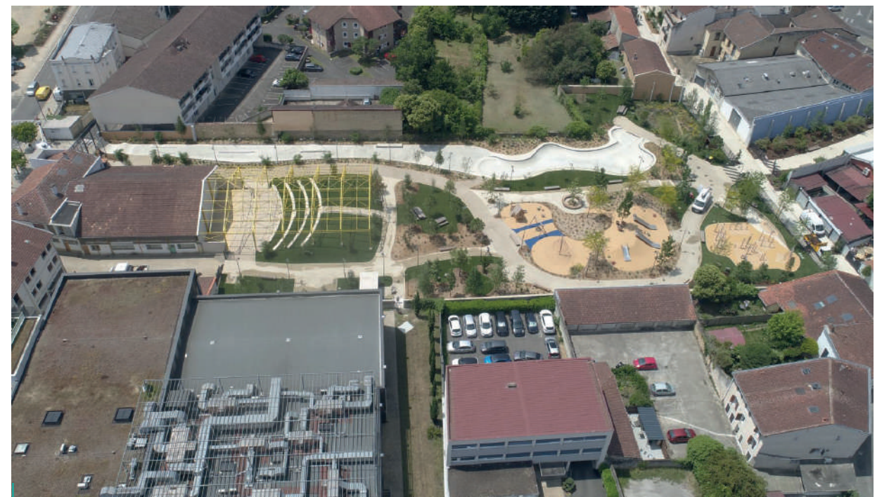
Vue aérienne - aménagement du jardin public Laulom
