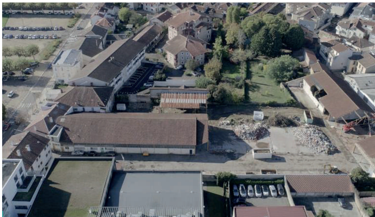
Travaux en cours - démolition
