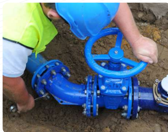
Intervention sur réseau d'eau potable
