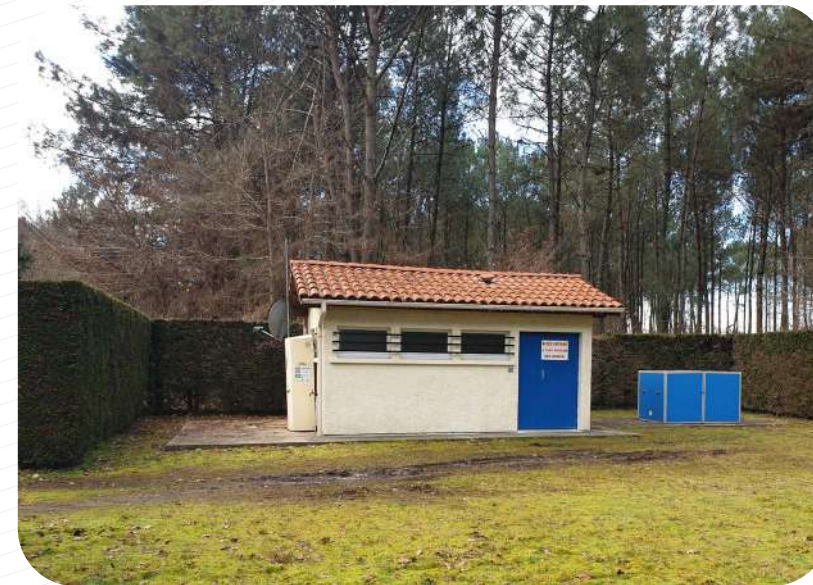
| Vue d'un forage d'eau potable
