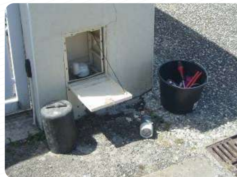
Changement d'un ancien compteur par un télérelève
