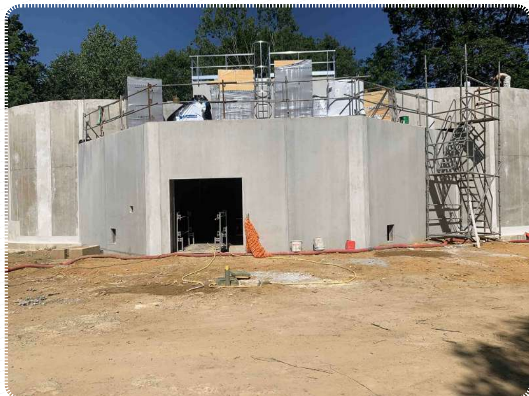
La future station de reprise de Lubet
