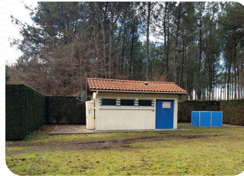
| Vue d'un forage d'eau potable
