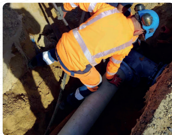
Intervention sur réseau d'eau potable
