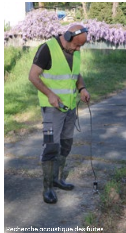
Recherche acoustique des fuites
